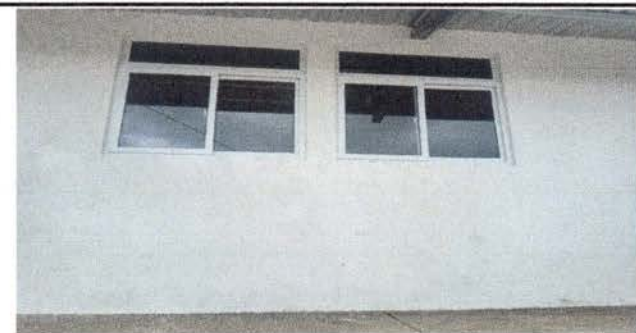
Foto 5: Ventana de PVC
