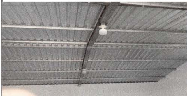
Foto 2: Sustitución de lámina
