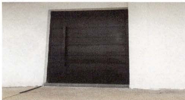
Foto 3: Sustitución de puerta
